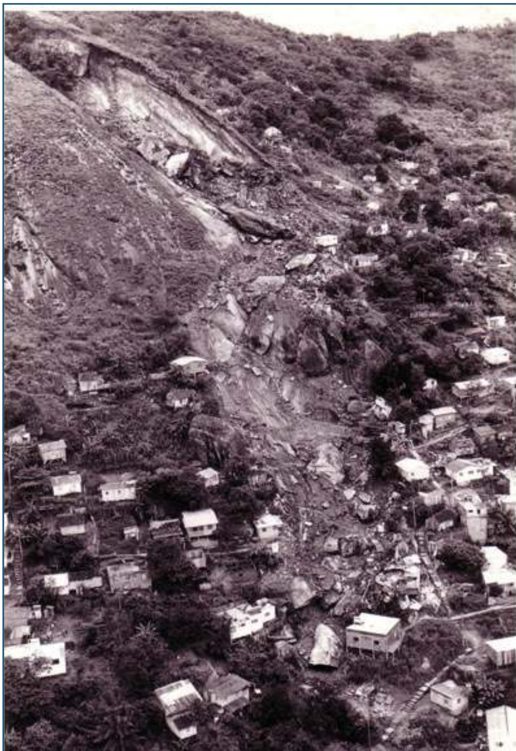
Figura 1 – Imagem após o deslizamento da pedra de aproximadamente 150 toneladas
