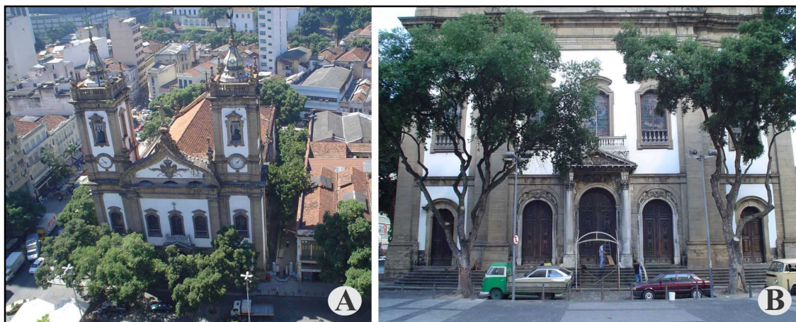
Figura 2 – Igreja de São Francisco de Paula, vista do alto (A). Fachada da igreja revestida, em grande parte, por blocos de granito (B).
