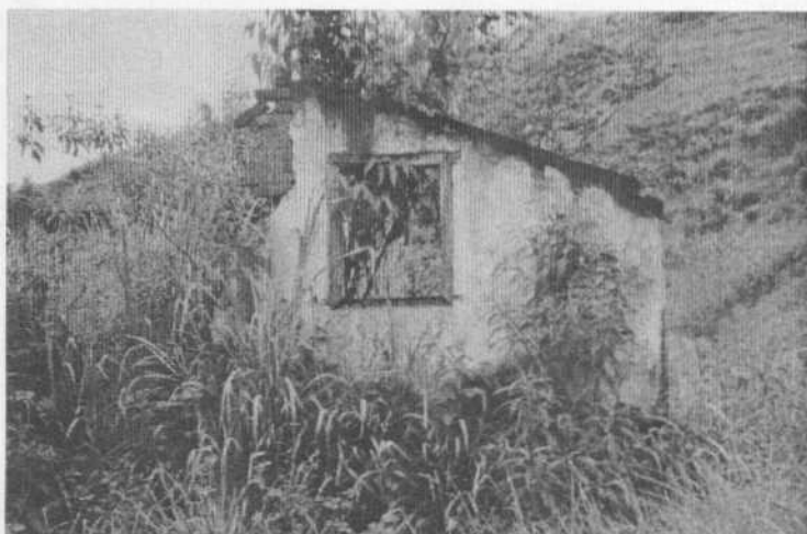
Figura 5 – Ruína de casa rural em Itaperuna (Grabois, 2000).
