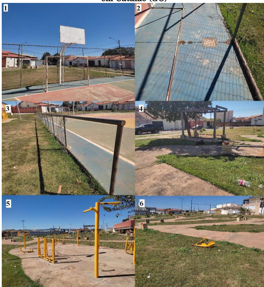
Figura 9 - Equipamentos estragados na Praça das Flores em Catalão (GO)
