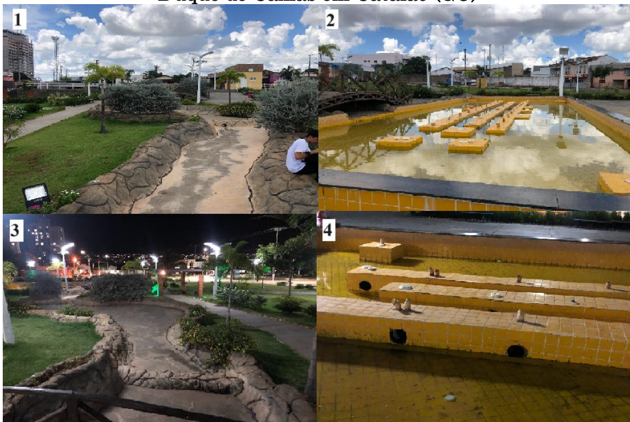
Figura 7 - Rio seco e fonte luminosa desligada na praça Duque de Caxias em Catalão (GO)
