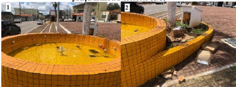
Figura 2 - Fonte luminosa com água parada e entulho na praça Irineu Nicoletti (GO)
