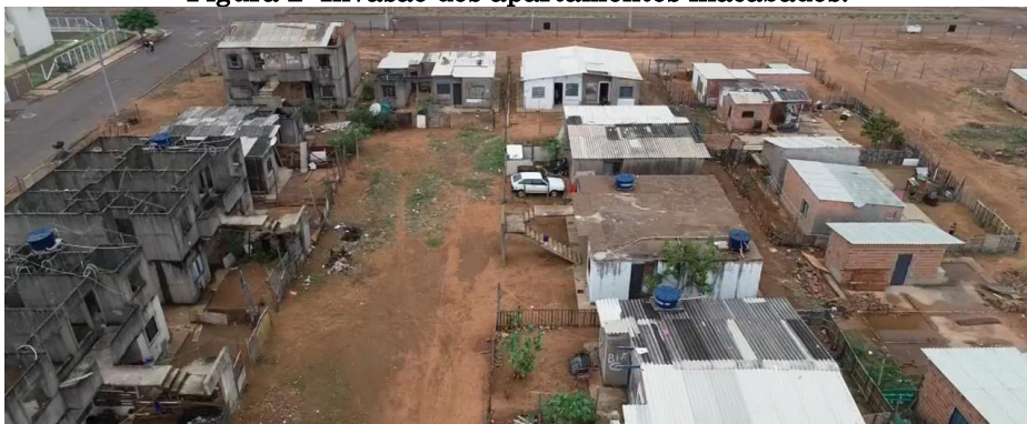
Figura 2: Invasão dos apartamentos inacabados.
