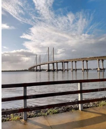
Imagem 03 - Aracaju: ponte Construtor João Alves
