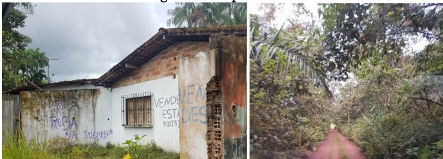
Figura 4 – “O que lhe causa temor?”. A esquerda, im3vel urbano no Bairro do Distrito Industrial, munic3pio de Ananindeua-PA, em localidade apontada como perigosa. A direita, vicinal de um assentamento, na 3rea rural do munic3pio de Santa B3rbara-PA, ambos na Regi3o Metropolitana de Bel3m-PA
