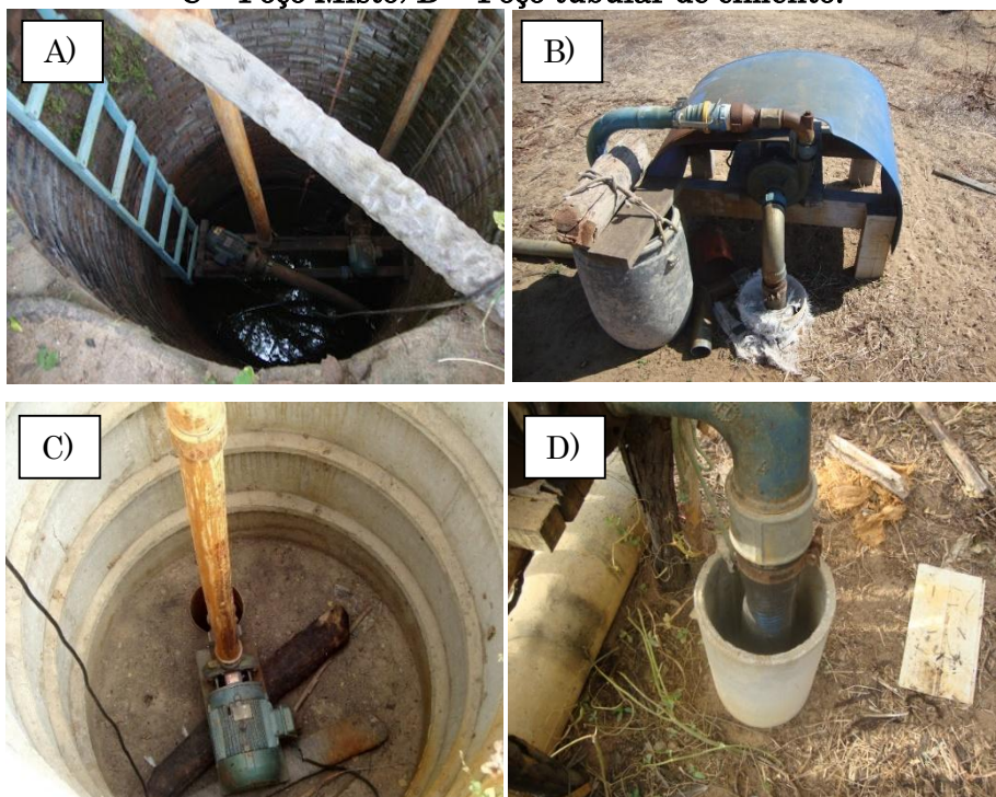
Figura 3 – Tipos de Poços. A – Cacimbão; B – Poço tubular de PVC; C – Poço Misto; D – Poço tubular de cimento.
