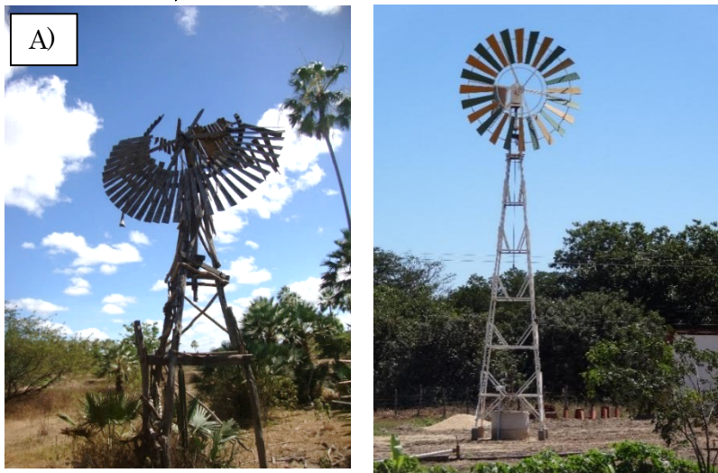
Figura 4 – Cata-ventos. A) Cata-vento de madeira inativo. B) Cata-vento metálico em atividade.
