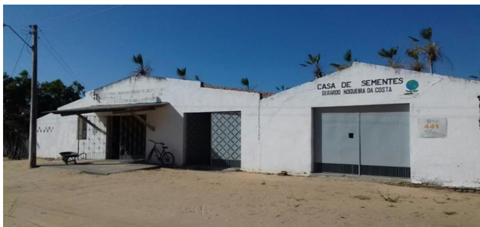
Figura 2- Casa de Farinha e Casa de Sementes em Lagoa dos Cavalos
