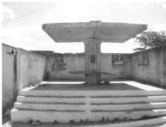
Figura 6: Sistema pré-pago desativado em Perpétuo Socorro distrito de Alagoinha - PE
