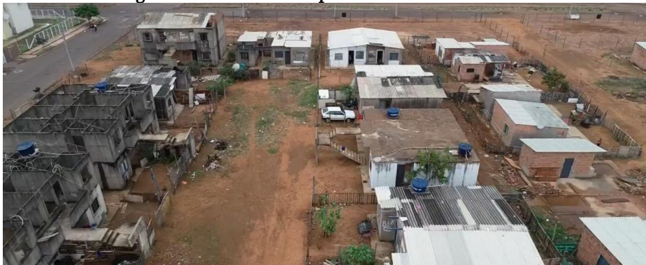
Figura 2: Invasão dos apartamentos inacabados.
