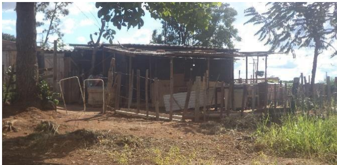
Figura 4: Casas feitas de latas, papelões, restos de rejeitos de construção.
