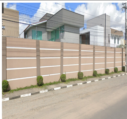
Fonte: Google Maps, (2019) Muro alto com cerca elétrica e arame farpado, condomínio Nature Ville
