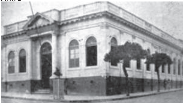
Antiga Escola Normal na década de 1910, atual Biblioteca Pública do Estado. Fonte: CUNHA, 1940.
