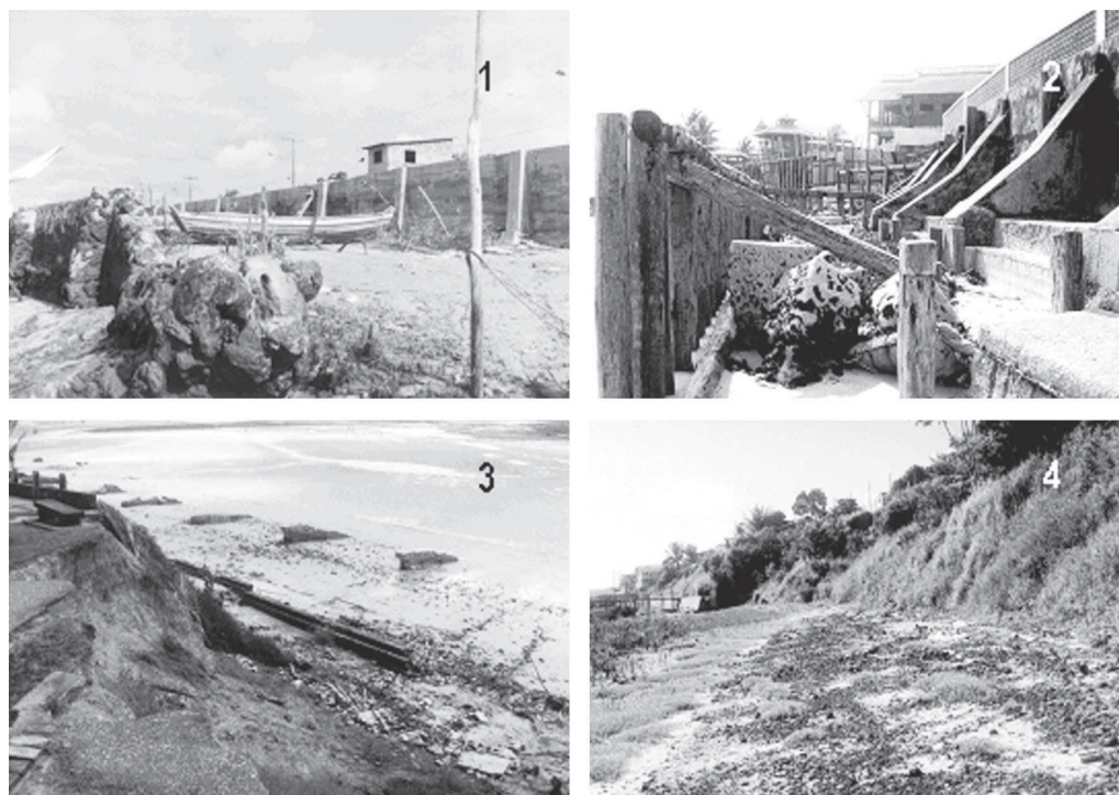
Figura 3: Exemplos apresentando o reduzido sucesso das estruturas de estabilização rígida na zona costeira do Estado do Pará. (1) Numerosas obras de proteção de mesmo tipo, (2) Numerosas obras de proteção de diverso tipo, (3) Obras de proteção isoladas, e (4) Obras de proteção para limitadas áreas.
