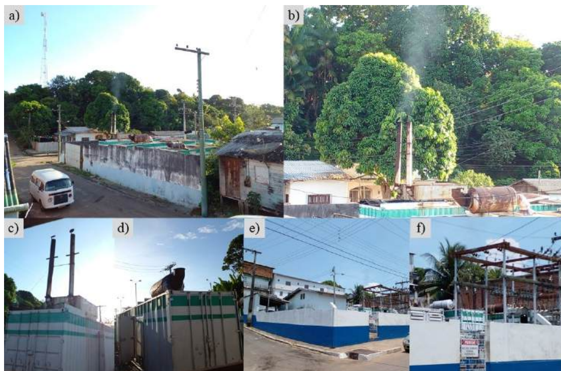
Figura 04: Termelétrica movida a óleo diesel nas cidades de Itapiranga/AM e Silves/AM: a) termelétrica localizada em fundo de vale; b) fumaça expelida pela queima do óleo diesel na cidade de Itapiranga; c) e d) contêineres com os motores e geradores; e) e f) usina térmica na cidade de Silves.
