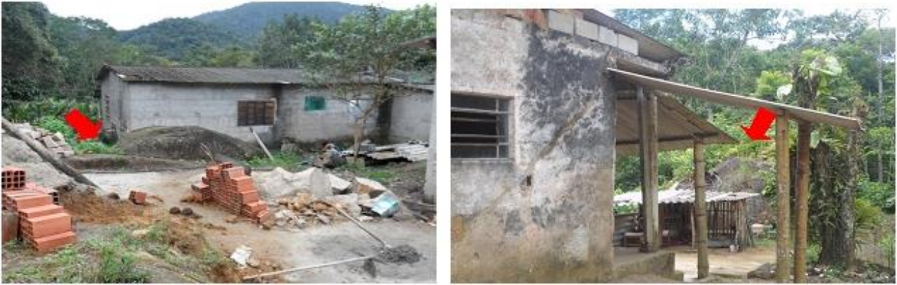
Figura 9: Áreas construídas sobre blocos (indicados pela seta) na Estrada do Cantagalo demonstrando a necessidade de ações voltadas ao gerenciamento de risco. Fonte: Autores
