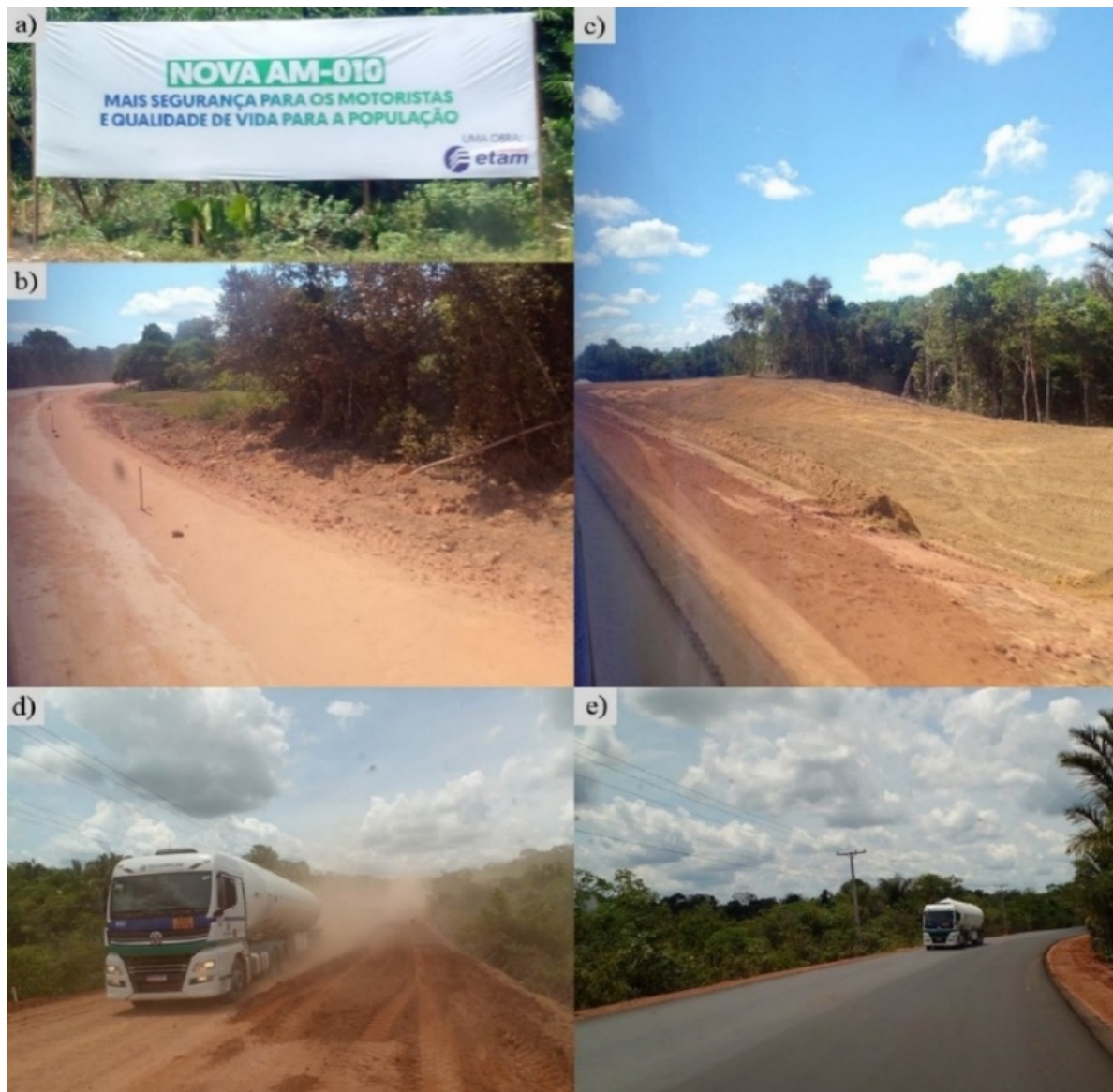
Figura 09: Modernização da rodovia estadual Manaus-Itacoatiara AM-010: a) placa indicando que a rodovia está passando por obras de modernização; b) trecho alargado da rodovia; c) trecho reconstruído e preparado para o recebimento da pavimentação asfáltica; d) trecho em obras e caminhão transportando GNL; e) trecho recém pavimentado e carreta de transporte de GNL.
