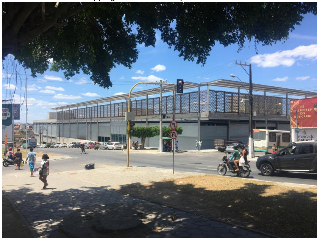
FIGURA 07: Shopping Cidade das Compras em fase com conclusão
