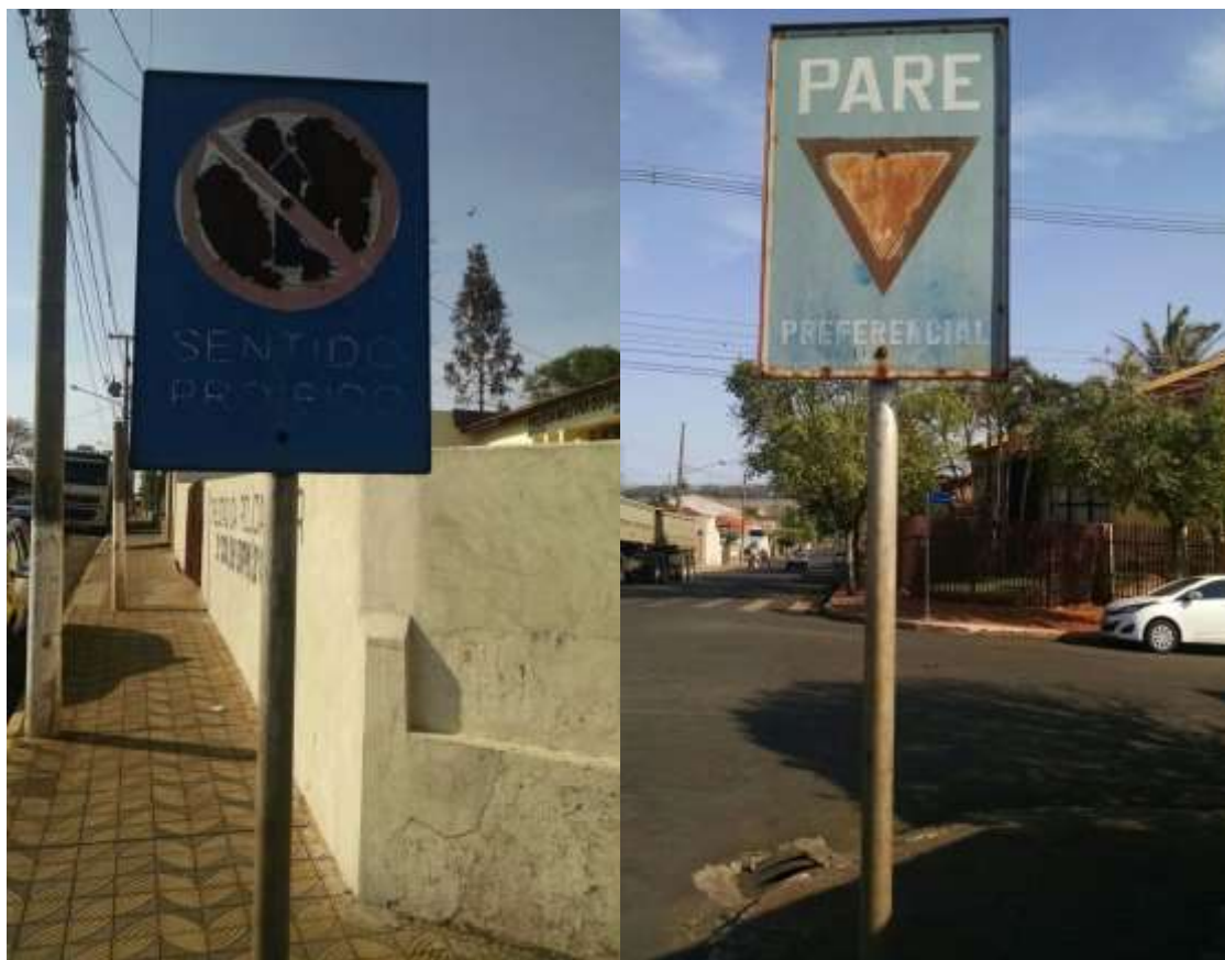
Figura 12. Santa Mariana (PR). Placa de sinalização em péssimo estado de conservação e placa de sinalização confusa e fora das normas de trânsito
