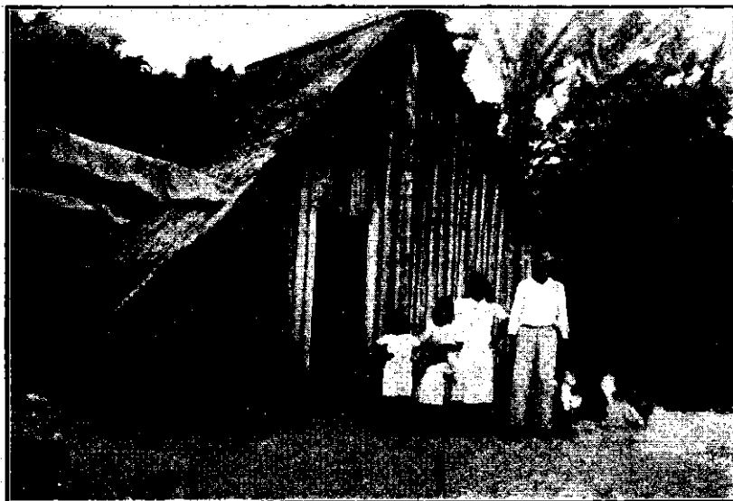
Foto n. 1 — Uma família caiçara e sua tosca habitação. — Tipo de casa dos mais pobres da zona, com apenas dois cômodos, sem janelas e onde a porta é substituída por uma prancha solta, que se prende por meio de embiras.
