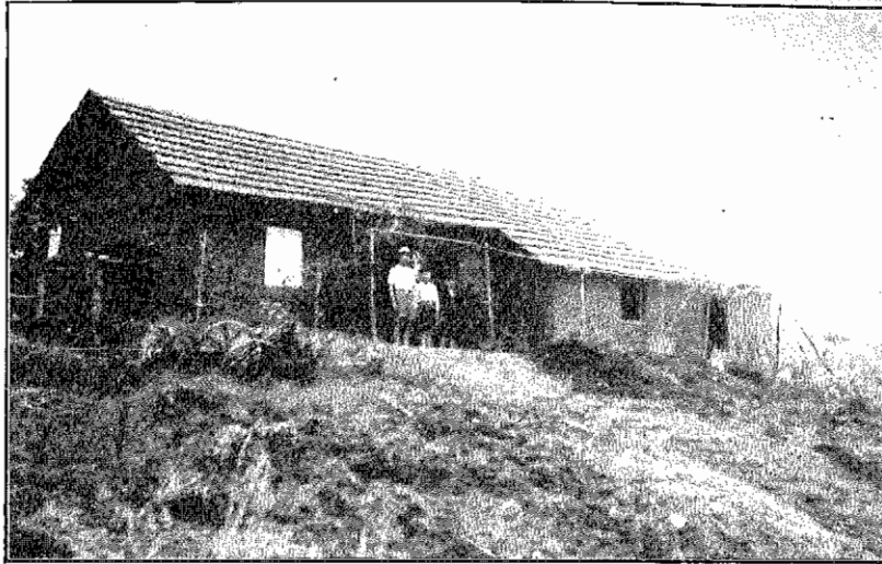
Foto n.º 5 — A habitação está localizada a meia-encosta, com um desnível de uns 6 metros sobre o nível das várzeas. É de pau-a-pique, coberta de telhas francesas. O "puxado" à direita, que corresponde a cosinha, é de tijolo. À frente da casa, os filhos do Sr. Daiji.
