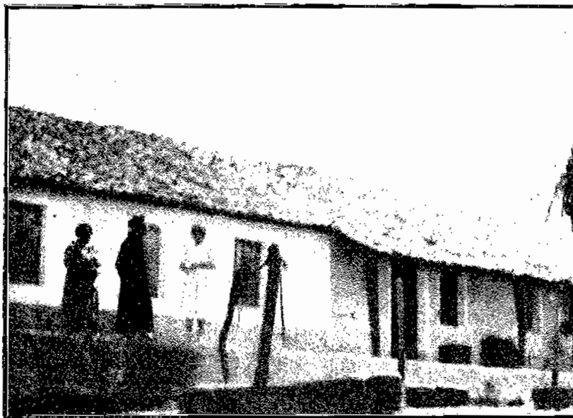
Foto 2 — Séde de um sítio de "pé-de-serra". Casa antiga, de alvenaria, ampla e com varanda na frente; telhas portuguesas. Mesmo sendo de um proprietário, é simples. A ausência de vidraças dá-lhe um traço de rusticidade. (Foto P. Petrone)
