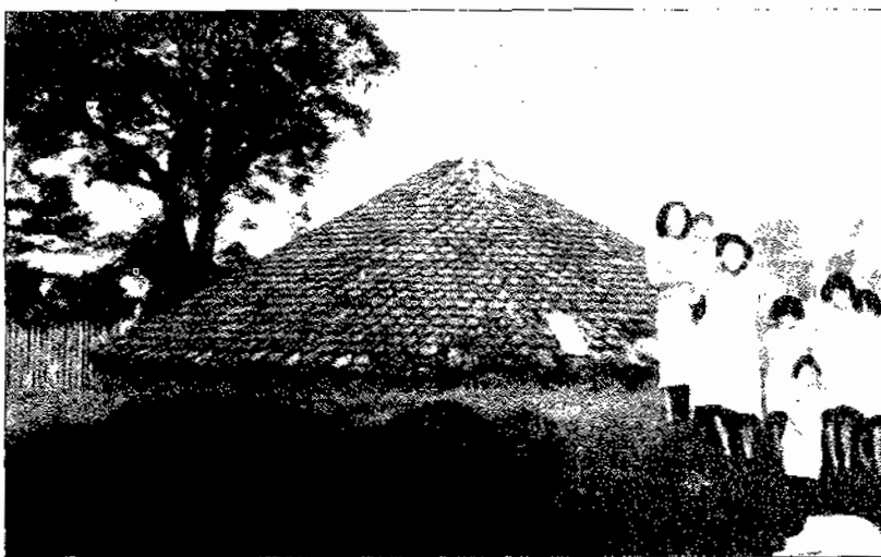
N. 12 — Curiosa cobertura de "tabuinhas" de um não menos curioso depósito de água, em Guaira. (Foto I. N. Takeda — setembro 1953).
