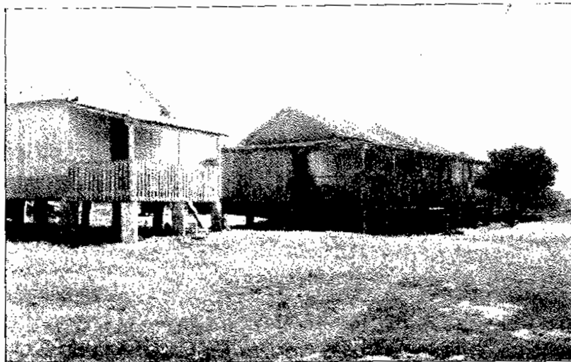
N. 14 — Quase todas as edificações de Pôrto 15 apresentam uma varanda na frente. Todas são construídas sobre pilares em virtude do problema representado pelas cheias. (Foto I. N. Takeda — setembro 1953).
