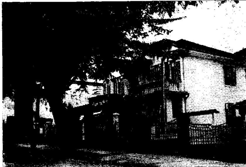
Foto n.º 15 — É bem outro o aspecto das residências do tipo médio, já na parte predominantemente residencial da Rua da Consolação.
