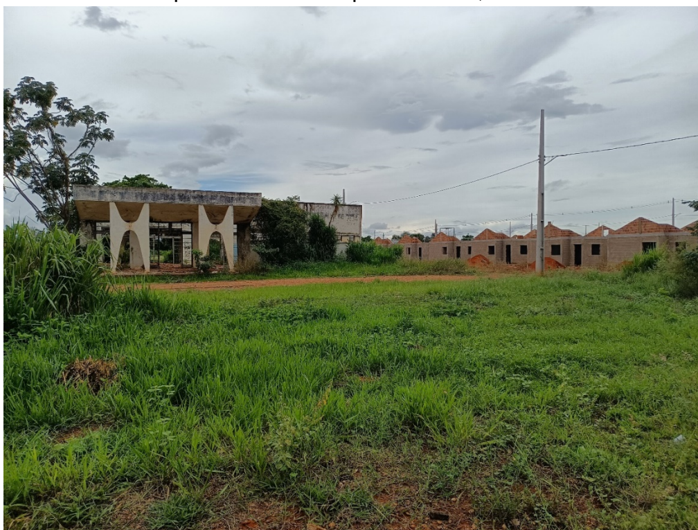
Imagem 3. Aspecto da construção de moradias populares em conjunto habitacional horizontal no bairro Exposição. A esquerda ruínas da entrada principal do antigo aeroporto da cidade de Aquidauana – MS, abril/2024
