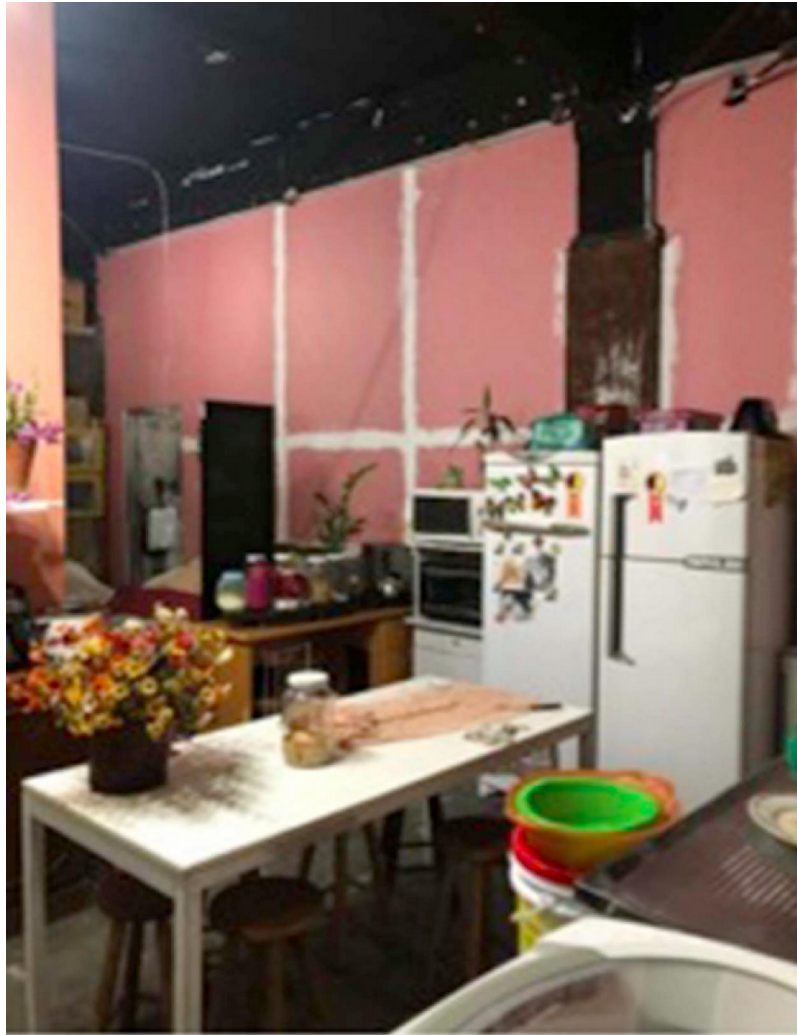
Figura 5. Paredes de dry wall instaladas e aguardando pintura.
