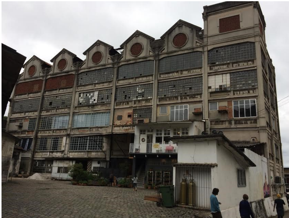
Figura 1. Pátio da Fábrica Bhering em 2016.
