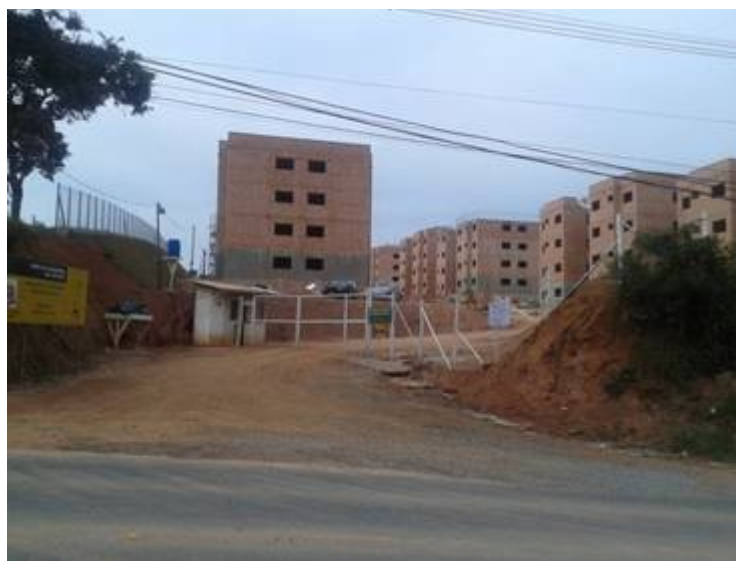
Foto 2. Empreendimento popular em construção em Itatiba.
