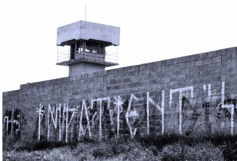
Figura 3 – Fachada do presídio Prof. Ataliba Nogueira, Campinas. Foto: Tiago Macambira (2007)
