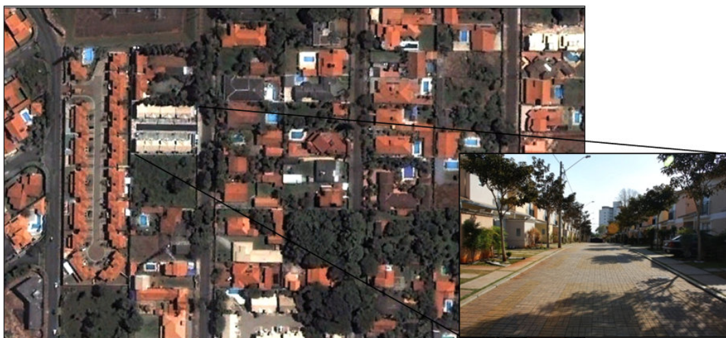
Figura 4 – Condomínio residencial de pequeno porte, Campinas (2010). Fontes: Google Earth e foto do autor
